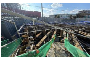
① 콘크리트 타설
