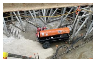
③ 열풍기 설치
