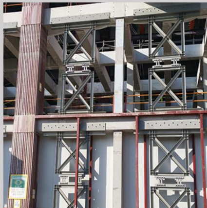
그림16. 댐퍼 설치 사례
