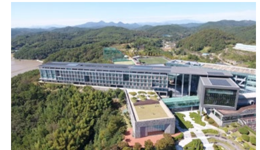
KB손해보험 사천연수원 내 태양광 발전 설비
